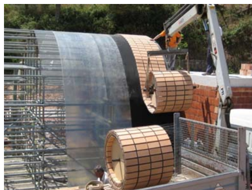
Fig.15- Extendido de la bobina
