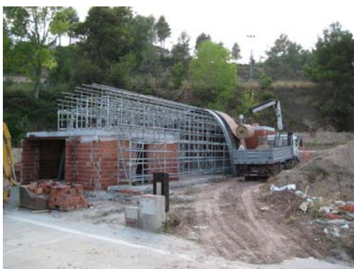
Fig.14- Cimbra y encofrado
