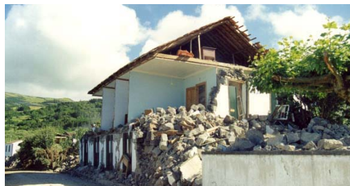
Figura 8: Queda da fachada sem ocorrer o colapso total da estrutura (Açores, após o sismo de 9 de Julho de 1998)
