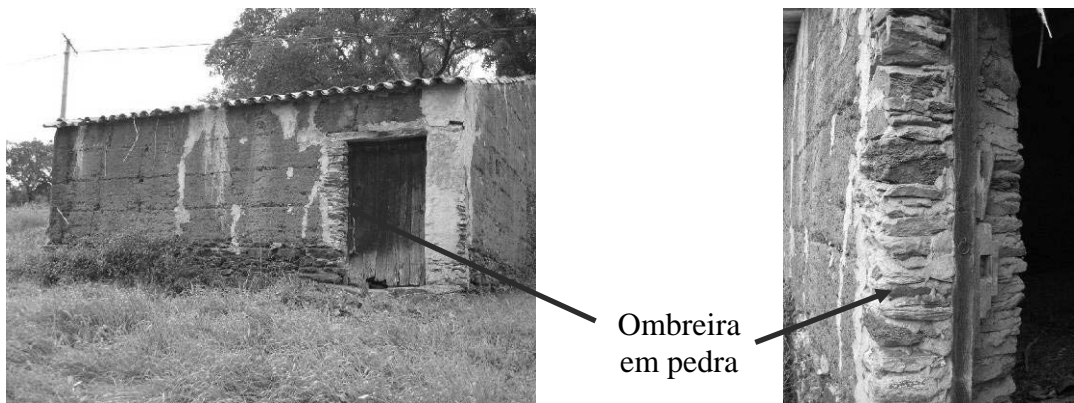
Figura 1 - À esquerda, habitação cujo material da ombreira da porta é a pedra e com um lintel em madeira e, à direita, pormenor da ombreira em pedra
