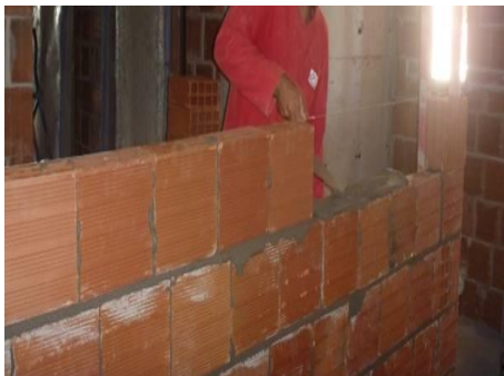
Figura 6 – Aplicação da argamassa na obra piloto de alvenaria de vedação.
