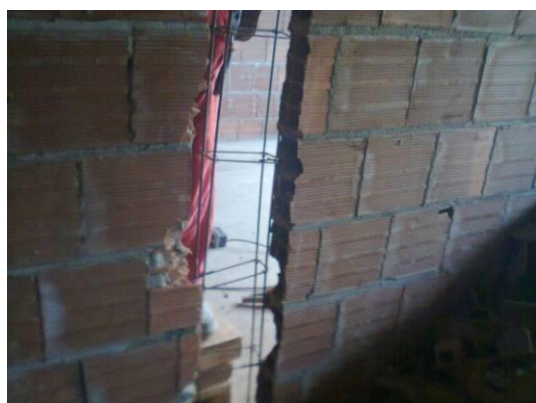
Figura 4 – Retrabalho na obra piloto de alvenaria de vedação.
