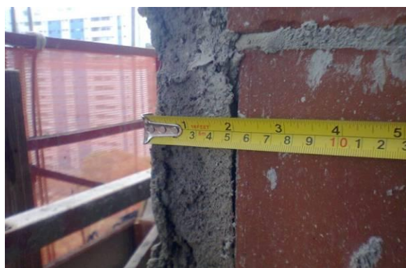
Figura 9 - Espessura da camada de revestimento na obra piloto de revestimento.
