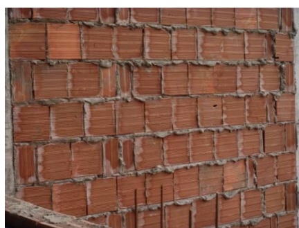
Figura 9 – Incorporação de argamassa na obra piloto de alvenaria de vedação.
