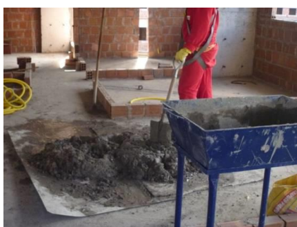
Figura 8 – Preparo manual da argamassa na obra piloto de alvenaria de vedação.
