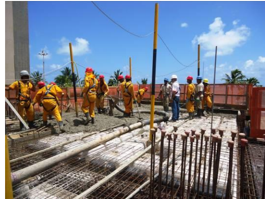
Figura 3 – Execução de laje na obra piloto de estrutura de concreto.
