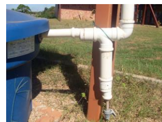
Detalhe da coleta após a passagem pelo telhado
